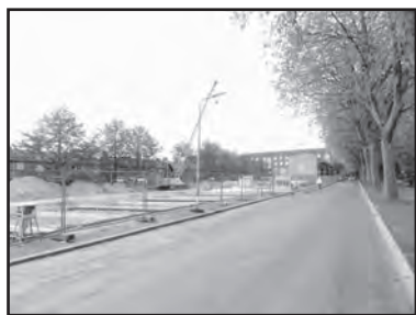
Op 22 mei 2013 was te zien dat de nieuwbouw in aantocht was.
