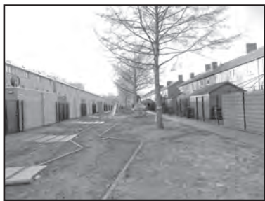
Op 25 november 2013 is te zien dat de binnentuin al vorm gaat krijgen.
