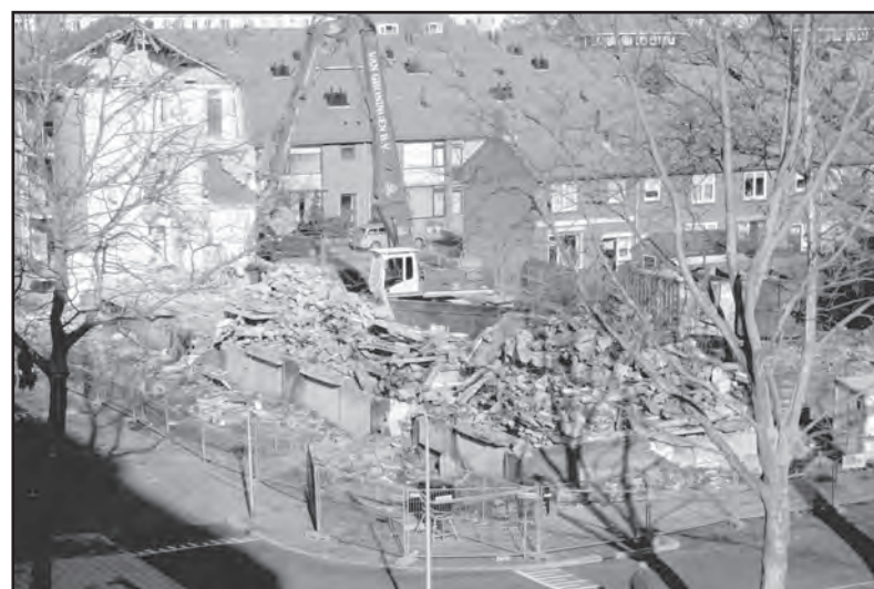
Op 4 december 2012 was men op de hoek van beide straten druk aan het slopen.
