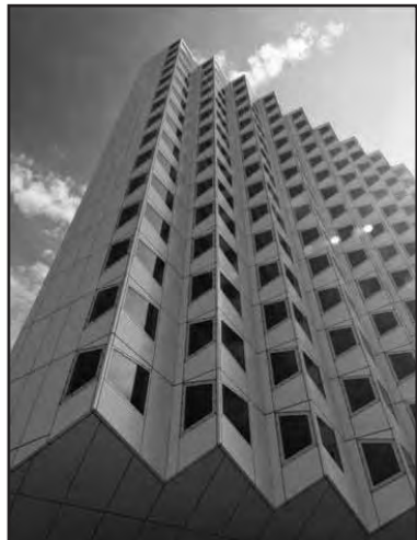
Een zaagtandgevel tegen de geluidsoverlast van de Kruithuisweg.
